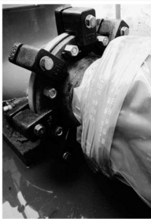
減圧弁フランジ接合部に採用
