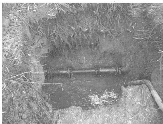
図-14 切落し（φ75）接続 この方法での補修が一番多くなりました。
