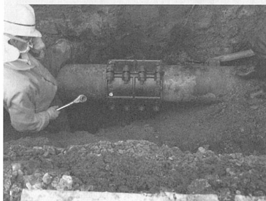
図-10 ヤノジョイント設置
