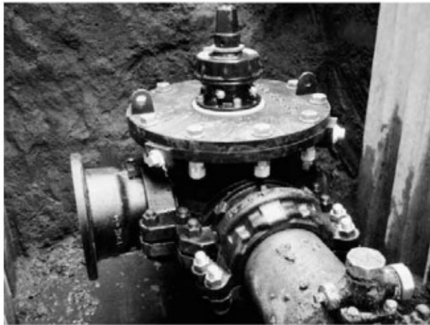
不断水用三方向切替弁による更新手順
