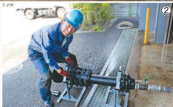
今年1月に発生した能登平島地震は、揺れが激しかった地域が都市ガスの供給エリア外だったこともあり、都市ガスの被害はほとんどなかった。しかし、同じ地下埋設である水道は、最大13万7千戸が断水し、その9割が解消したのは発災から11週間後だった。1995年9年に断水しないで工事を行う「不斷水工法」を開発して以来、断水の解消とともに耐震化にも取
