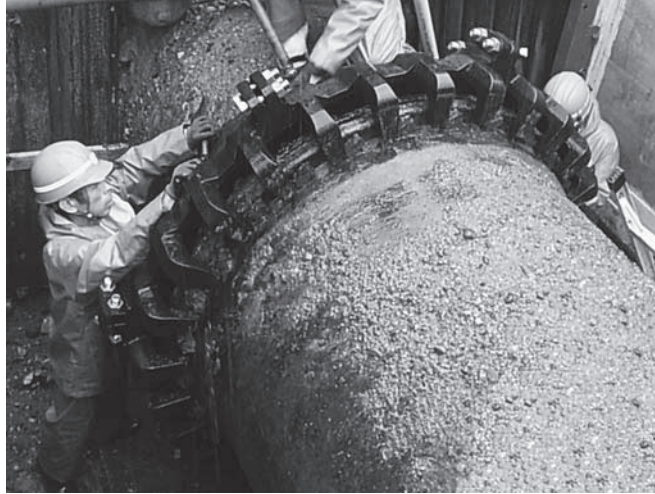
設置工事の様子
