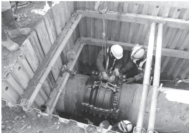
1月29日に行われた設置工事
