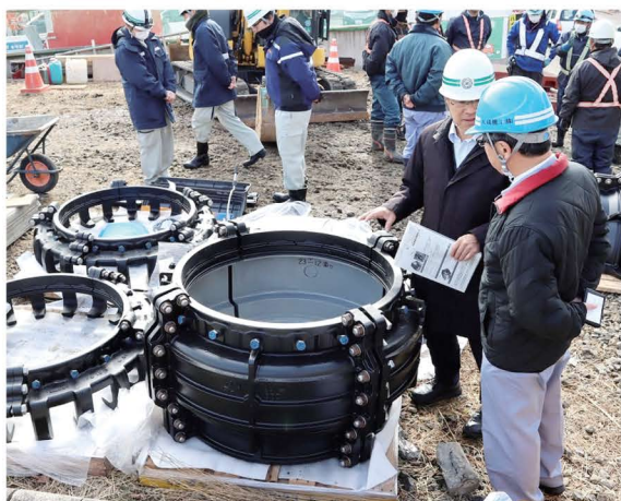
耐震継ぎ輪を確認する宮島教授(手前左)
