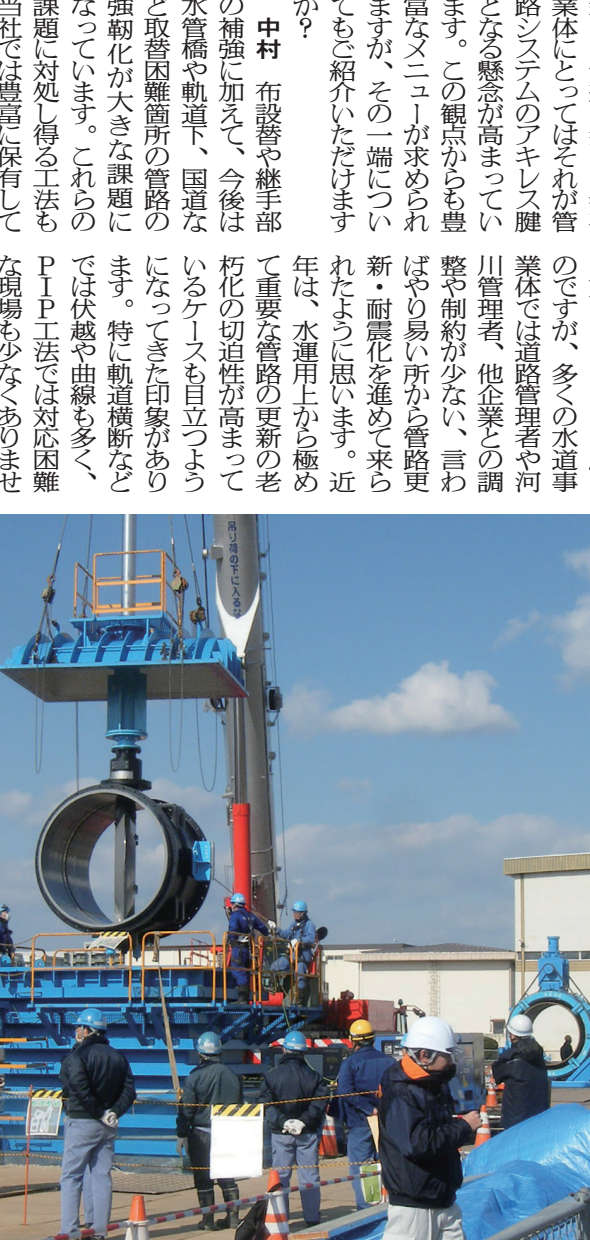
φ2000のインサートバルブ工法の工事風景
