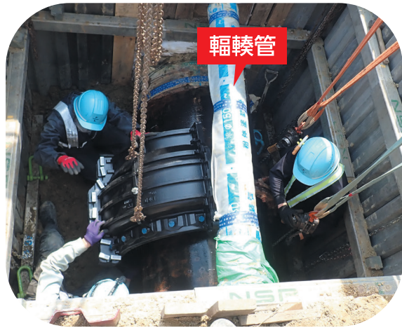
輻輳管での耐震継ぎ輪設置
