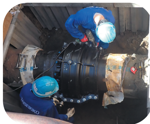
施工状況(耐震継ぎ輪)
