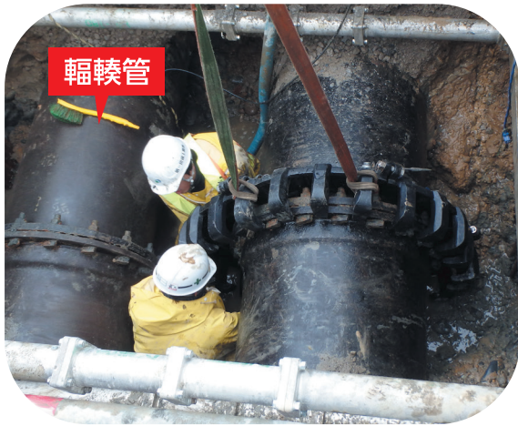
輻輳管での耐震補強金具設置
