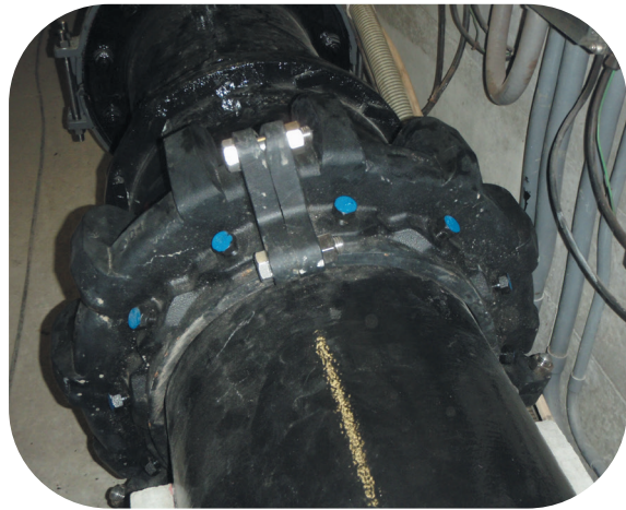
耐震補強金具の設置状況
