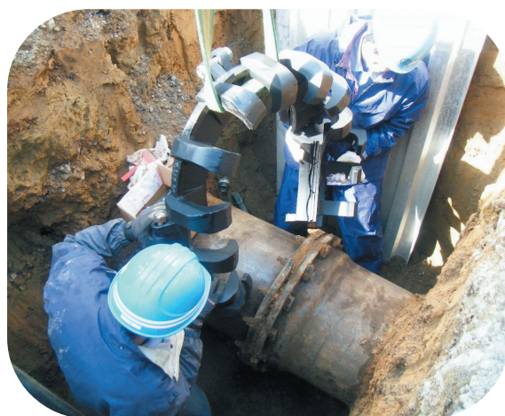
施工状況(耐震補強金具)
